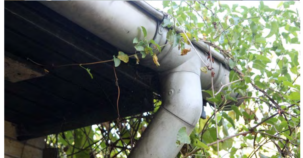
Dachrinne und Fensterprofile aus PVC
